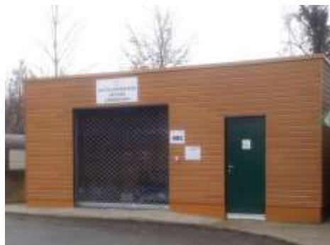
Local d'accueil des déchets dangereux
