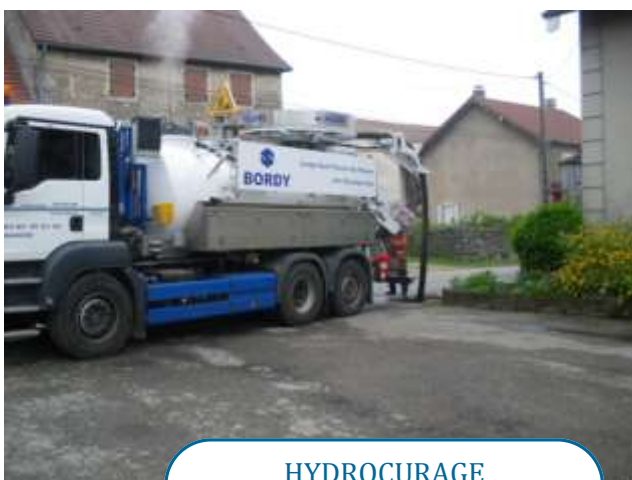
TRAVAUX GRANDVILLARS- RUE BELLEVUE- GRANDS CHAMPS
