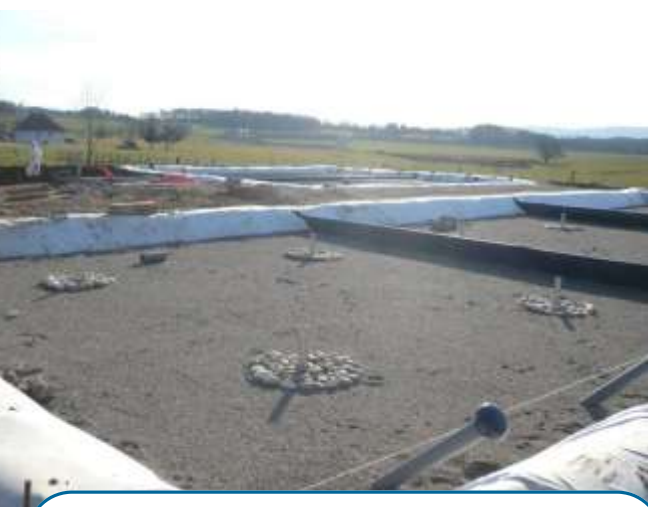
TRAVAUX CROIX- STATION ET RESEAU
