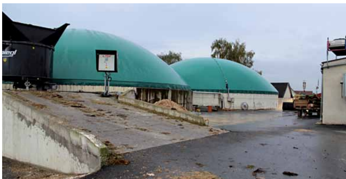
Les deux digesteurs et leurs membranes vertes sous très faible pression où le digestat produit le méthane.
