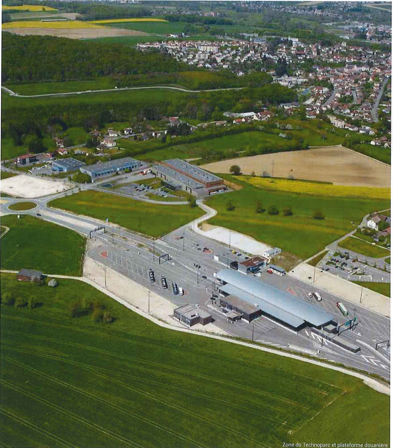
Zone du Technoparc et plateforme douanière
