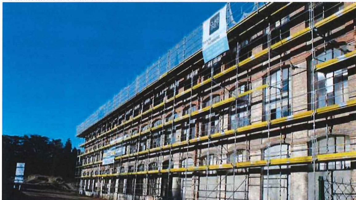
La rénovation des toitures
