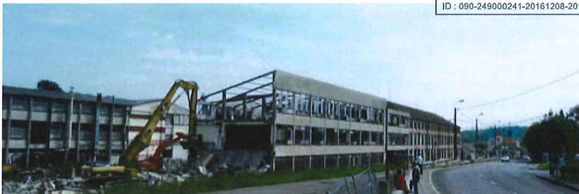
La démolition des bâtiments sans valeur architecturale
