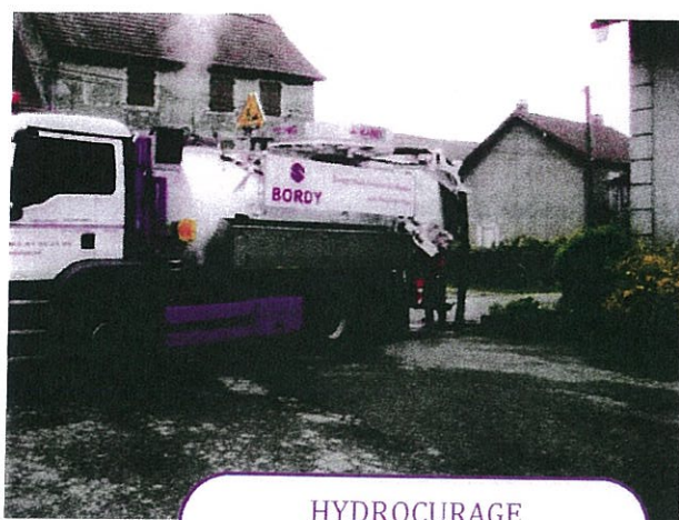
TRAVAUX GRANDVILLARS- RUE BELLEVUE- GRANDS CHAMPS
