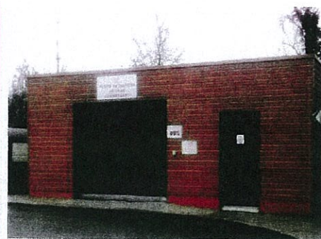
Local d'accueil des déchets dangereux
